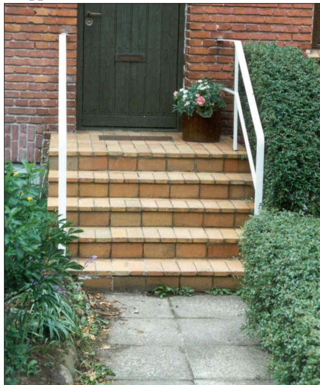
Foto 16. Original trappe i delområde 1 med gule klinker og gelænder afhvidmalet fladjern.
