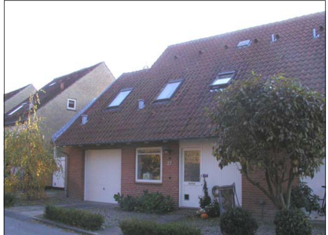
Foto 21. Et godt eksempel på rækkehusene 27-29 med hensyn til vinduer, garage, træbeklædning og dør. Alt træværk står i dag i dækkende hvid maling, men træbeklædning og porte kan males i en dækkende sort maling, som det oprindelige.
