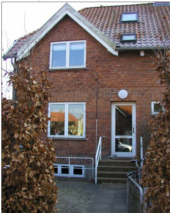
Foto 5. Et fint eksempel på facade, vinduer, dør og tagvinduer for rækkehusbebyggelsen i delområde 1. Her er istandsat med respekt for det oprindelige.
