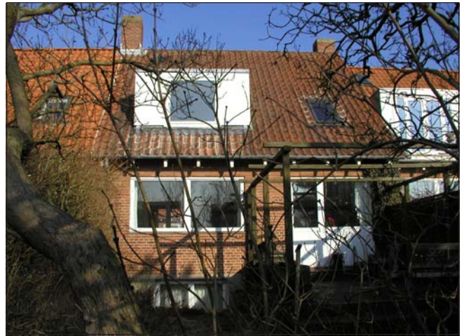
Foto 11. Et velbevaret eksempel af rækkehusbebyggelsen set fra havesiden i delområde 3 med hensyn til vinduesopdeling, terrasse dørparti, kvist og tagvindue.
