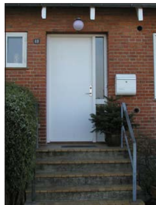
Foto 2. Den karakteristiske dørtype for delområde 2. Døren er malet med en dækkende hvid maling og har et smalt glasparti med en vandret sprosse.
