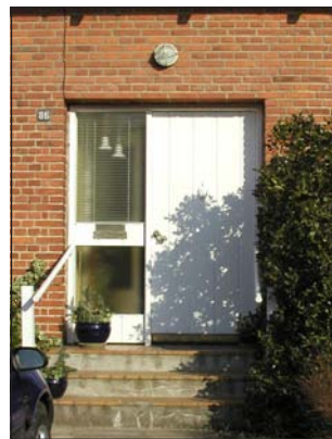
Foto 4. Den originale dørtype for delområde 4. Døren er malet med en dækkende hvid maling og har et glasparti med en vandret sprosse.
