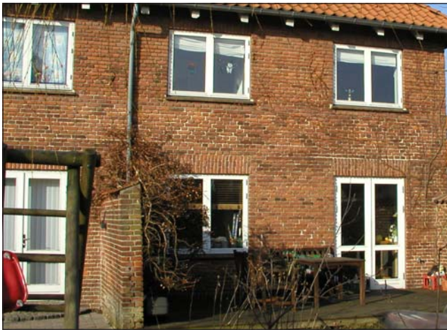
Foto 9. Et fint eksempel af havesiden for rækkehusbebyggelsen i delområde 1 med velproportionerede vinduer og terrassedøre i den oprindelige udformning, samt halvmuren der rytmisk opdeler de smalle parceller og skærmer ved terrassen.
