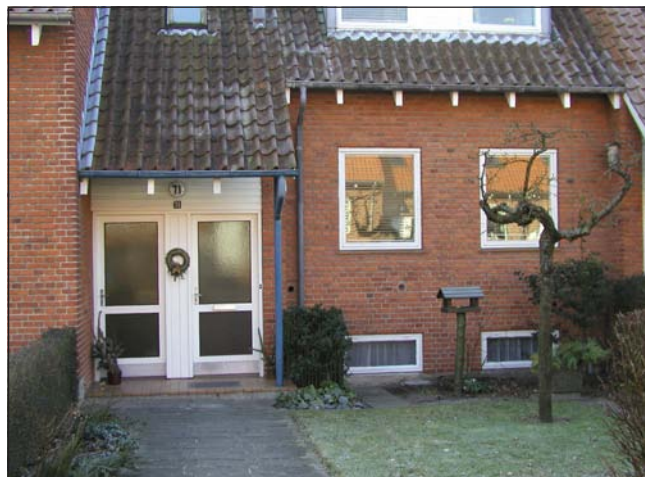
Foto 7. Et fint eksempel på rækkehusbebyggelsen i delområde 3 med dørparti, vinduer, nedløbsrør, hvide synlige spærender samt en grøn indbydende forhave. Det er vigtigt for helheden i bebyggelsen at facaderne spiller sammen med hensyn til dør- og vinduesplacering, materialer, farver og selve udformningen af vinduer og døre.
