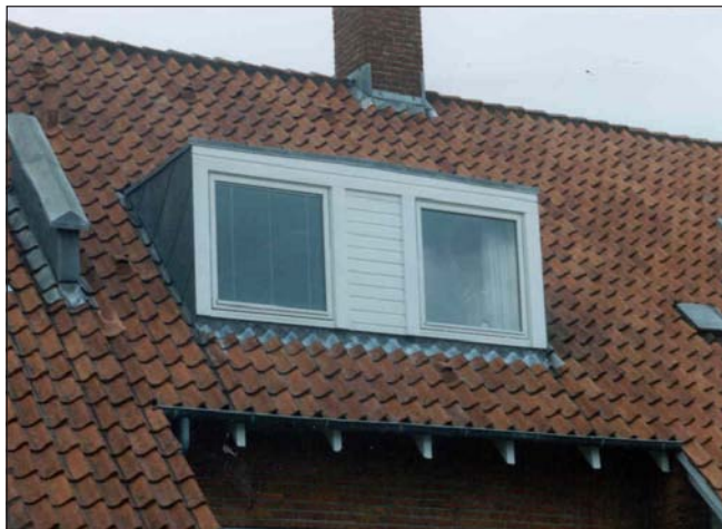
Foto 13. Delområde 3, hvor der mod gadesiden er en bred kvist med fladt tag, umalet zink på flunke og to vinduer med vandrette profilbrædder mellem vinduer.
